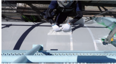
水管橋 (撤去状況)
